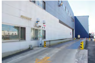
・トラックスケール 荷卸前後の重量を計測することで 廃棄物の重量を測定します
